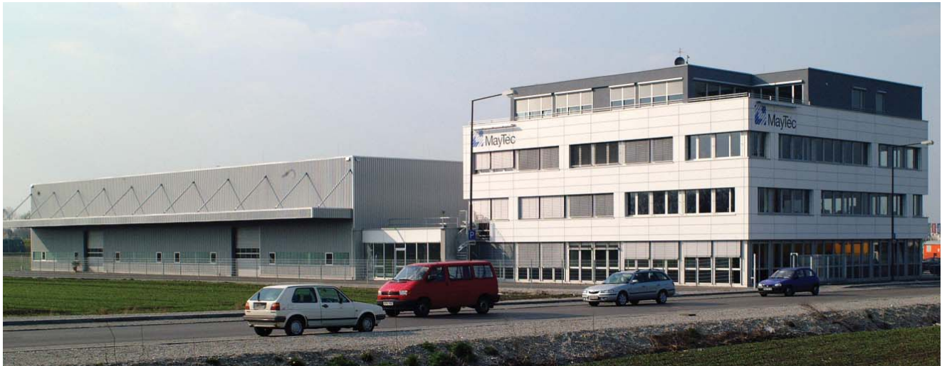
MayTec GmbH in Dachau
